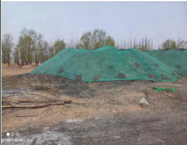
辅助生产设施区临时苫盖
