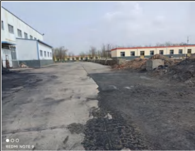
生产区场内硬化
