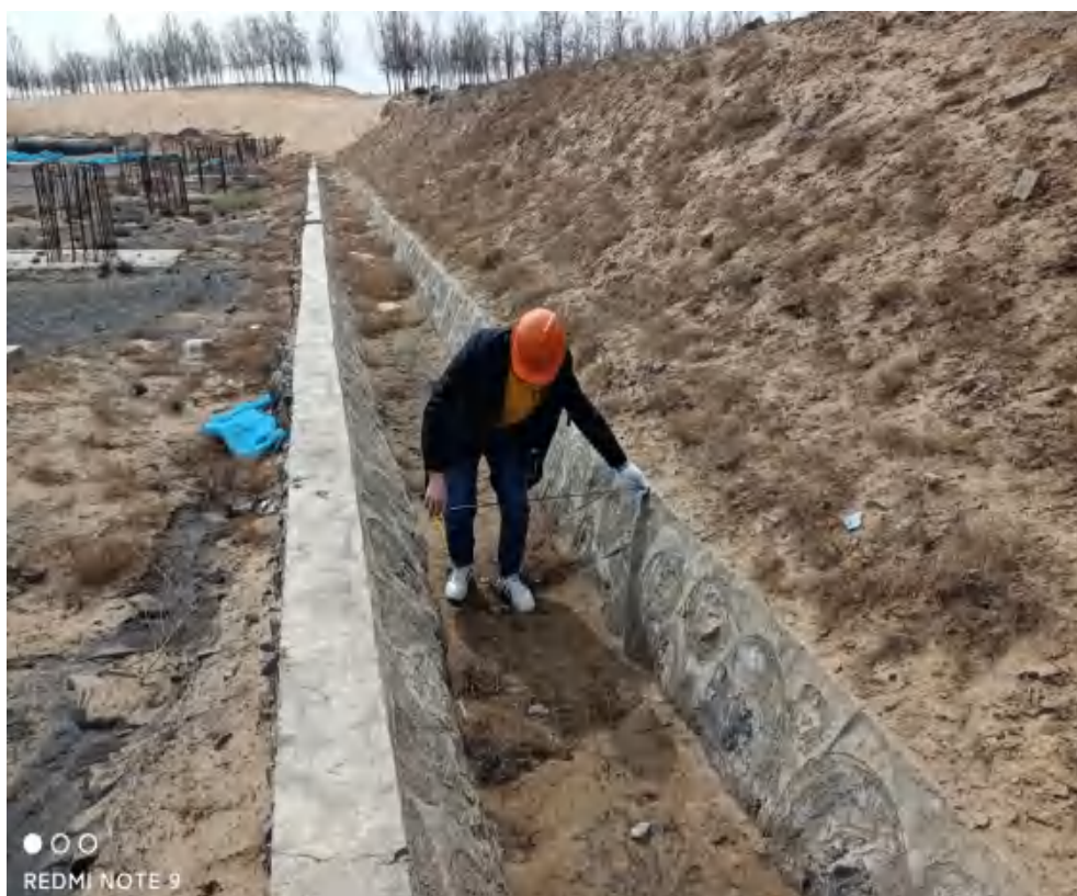
图 2-2 排水沟抽样调查
