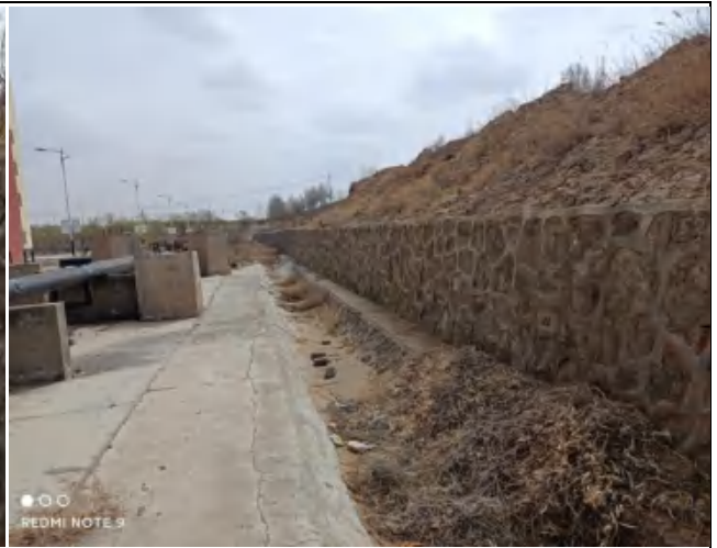
场地南侧挡墙及排水沟
