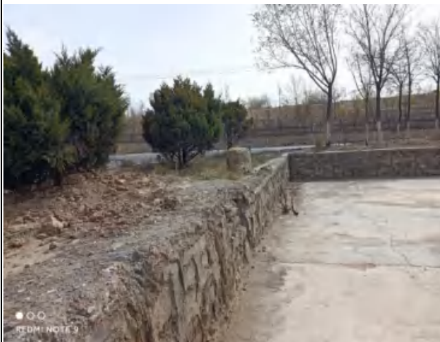
场地东侧挡墙
