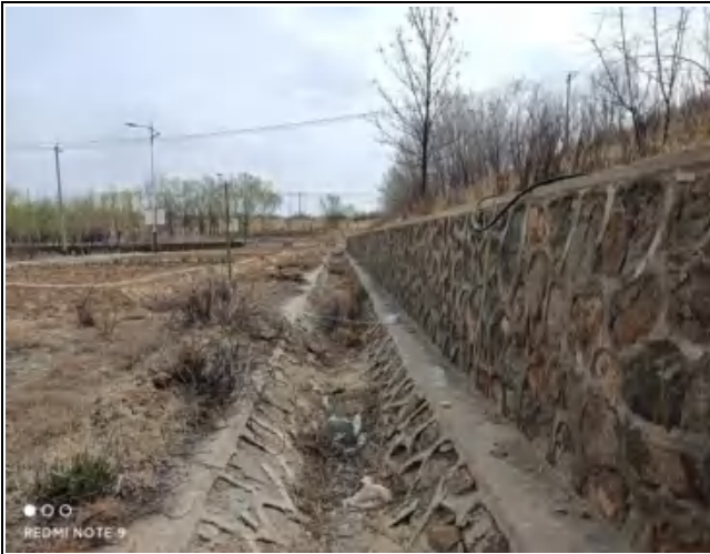
场地南侧挡墙及排水沟
