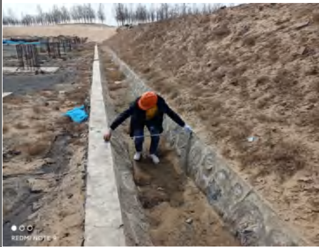
工程措施量测
