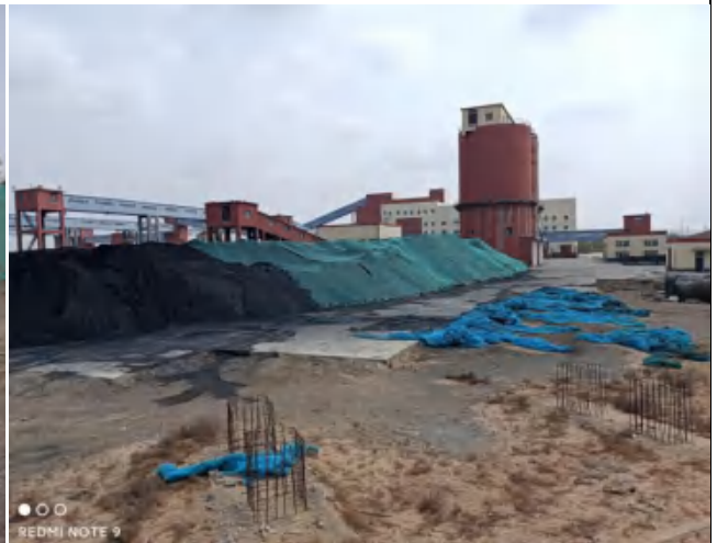
生产区临时苫盖
