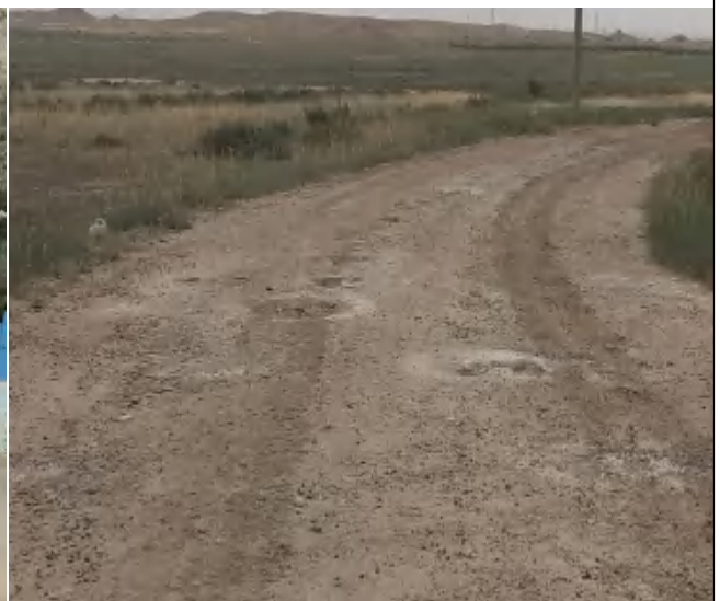
进场道路碎石压盖措施
