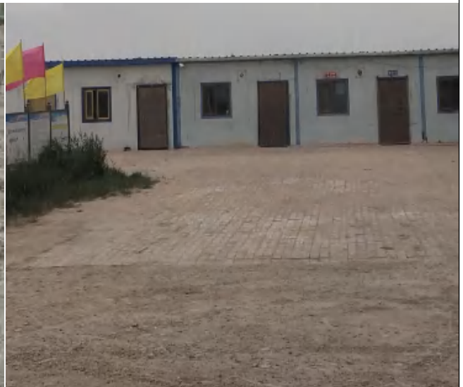
生活区透水砖铺装措施
