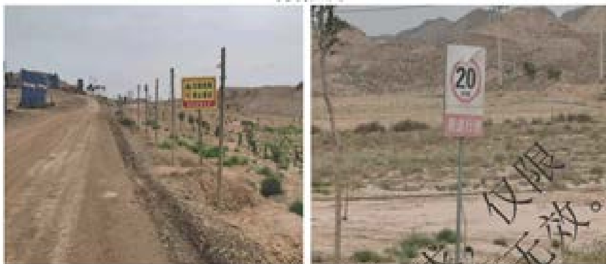
现场安全警示标识牌
