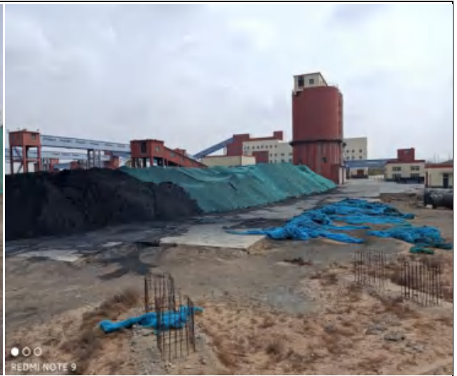
生产区临时苫盖
