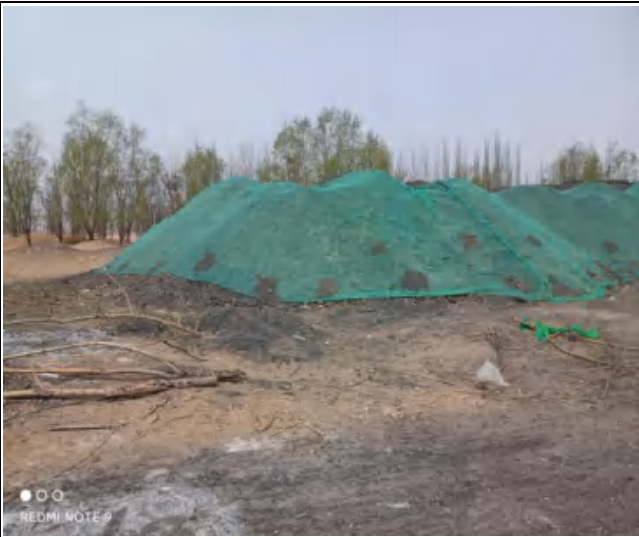
辅助生产设施区临时苫盖
