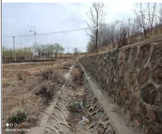
辅助生产设施区挡墙及排水沟
