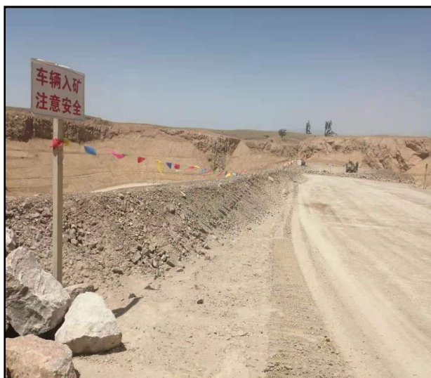
采区运输道路挡车墙及警示标志
