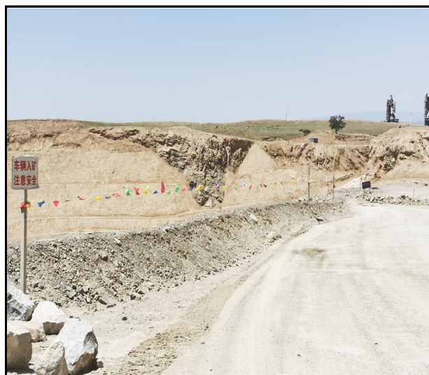
采区运输道路挡车墙及警示标志
